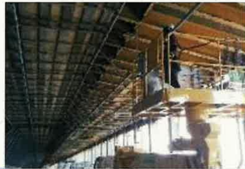
洞門内の梁部材補修状況
