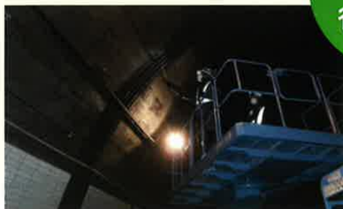
トンネル内設備の点検
