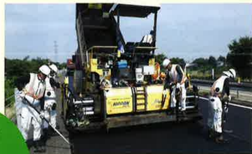
舗装路面の補修
