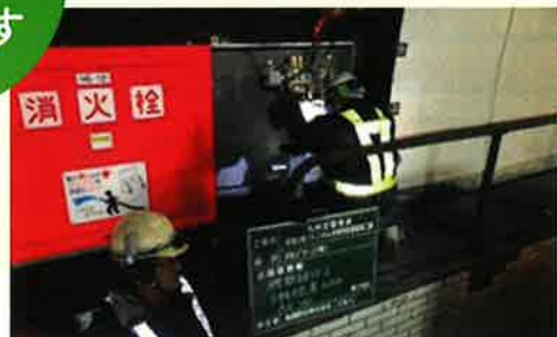
非常用設備更新
